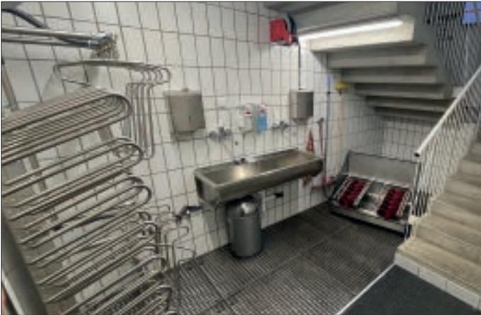
In der neuen „Schmutzschleuse“ findet eine Trocknungsanlage für Stiefel und Einsatzbekleidung ebenso Platz wie ein großes Waschbecken und eine neue Stiefelwaschanlage.
